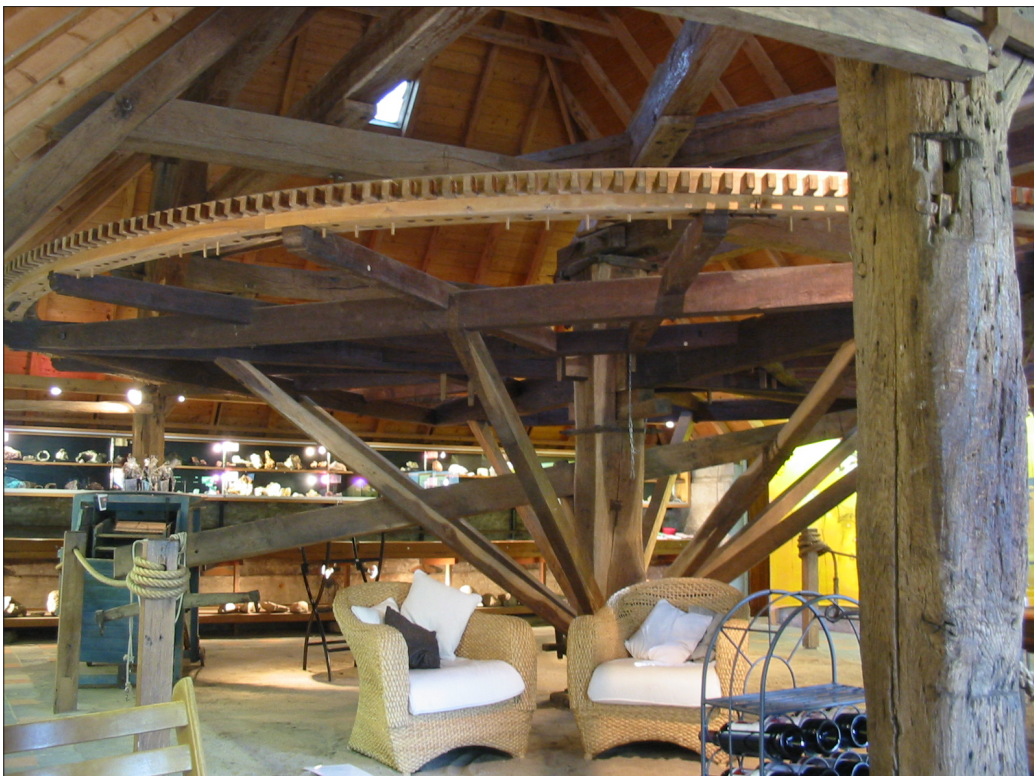
Afbeelding 90. Foto van het interieur van de rosmolen te Zeddam. De molen is in 1974 herbouwd naar de originele bouwtekeningen uit 1546. De diameter van het spoorwiel is in deze molen 7,29 m. Bron: Wikipedia.org.
