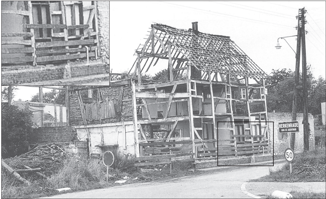
Afbeelding 84. Houtskelet van een historisch pand aan de Dorpsstraat in Herkenrade (Zuid-Limburg). De staanders van het gebint met de horizontale beplanking aan de buitenzijde van het huis, is mogelijk vergelijkbaar met de balk die bij het huidige onderzoek aan de rand van een mestkuil is aangetroffen (V75). Naar: Berends 1999, foto 34.
