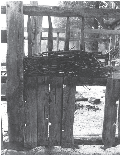
Afbeelding 24. Voorbeeld van een wand met verticale planken en vlechtwerk. Op de onderste regel is een groef te zien, waarin van oorsprong stijlen van een vlechtwerk of verticale planken in hebben gezeten. In een latere fase zijn de planken aan de regel vastgenageld. Uit: Voskuil 1979, afb. 96.
