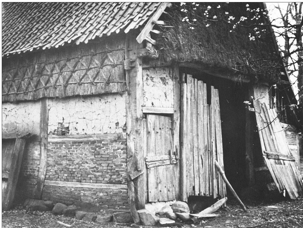
Afbeelding 28. Schuur met een zijmuur van vakwerk waarbij de onderste vakken zijn opgevuld met baksteen. De bakstenen rusten op grote natuustenen keien. De voorgevel van het Gorcumse huis zou op een dergelijke wijze kunnen zijn opgebouwd. Uit: Voskuil 1979, afb. 58.
